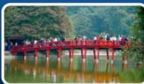
สะพานแสงอาทิตย์
